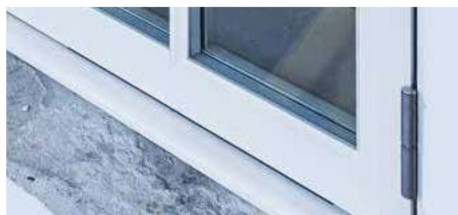
Bottenkarm med 68mm dropprofil
