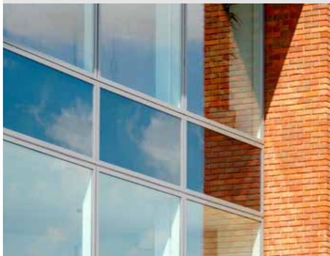
VELFAC 200 FÖNSTER MED VENTILATIONS PANEL OCH IKKE-VENTILERAD CEDERTRÄSFYLLNING
