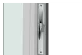
Dold spanjolett för att frigöra rörlig post i 2-luft element med fönsterlås.
