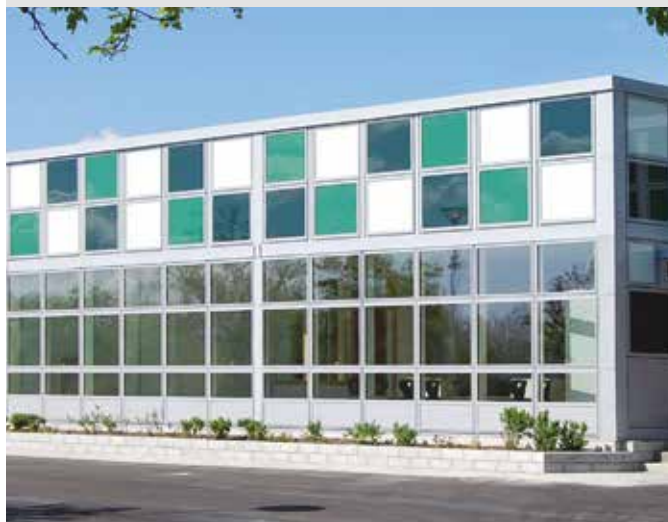
BURSPRÅK MED VELFAC RIBO FÖNSTER OCH VENTILERAD FYLLNING
