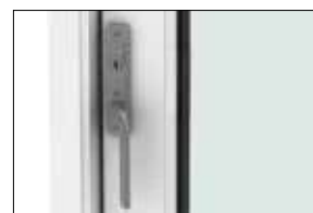
Spanjoletthandtag i terrassdörr. Sett intillfrån. Utillfrån lås mot tillägg.
