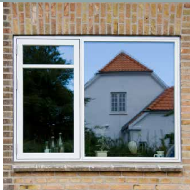
Konstruktion på karm/båge som under 1960-1980
